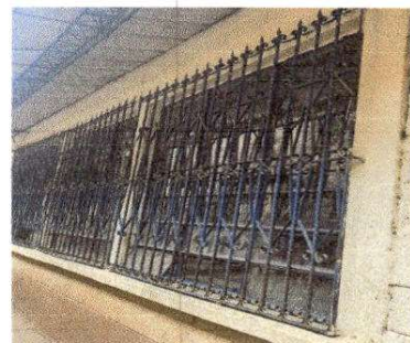
Foto2: Sustrucion de balcones de metal
