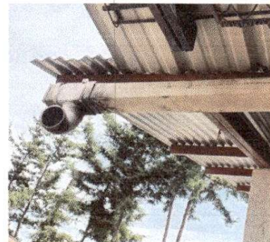
Foto 4: Foto 2: Sustrucion de canal de pvc, reparacion de bajada de agua pluvial tubo pvc 3" y sustitucion de soporte o pescante de metal para canal
