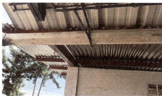
Foto 3: Foto 2: Sustrucion de canal de pvc, reparacion de bajada de agua pluvial tubo pvc 3" y sustitucion de soporte o pescante de metal para canal
