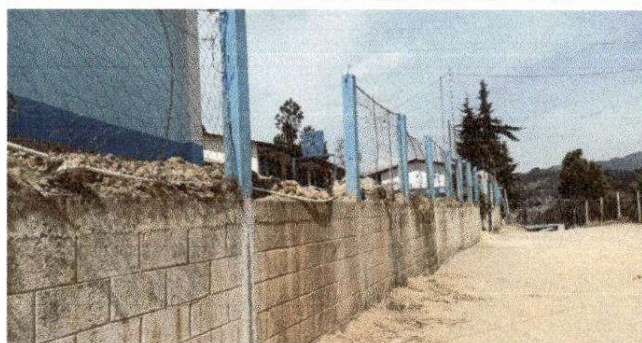
Foto 5: Reparación de tubo hg y malla galvanizada
