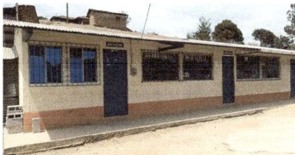
Foto1: Sustrucion de balcones de metal
